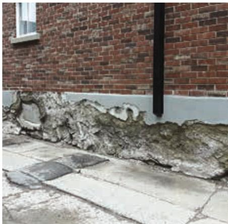
est plus fragile, car il contient un faible ratio de ciment. Ce béton a donc tendance à s'effriter avec le gel et l'eau présente dans le sol passe facilement dans les murs à cause de la quantité de cailloux contenue dans le béton.
