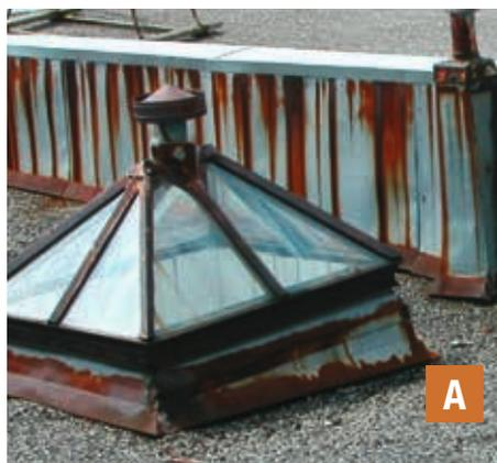
pieds des supports électriques, le lanterneau et son pourtour, vérification de la tôle à la recherche de rouille, ainsi que des joints non calfeutrés. Regardez la corniche pour vérifier la tôle, les joints soudés, les différentes parties des décorations de ferblanterie, l'état général de la peinture. Si vous notez des faiblesses concernant certains de ces points, il serait prudent de contacter une firme spécialisée en toiture ou en ferblanterie.
