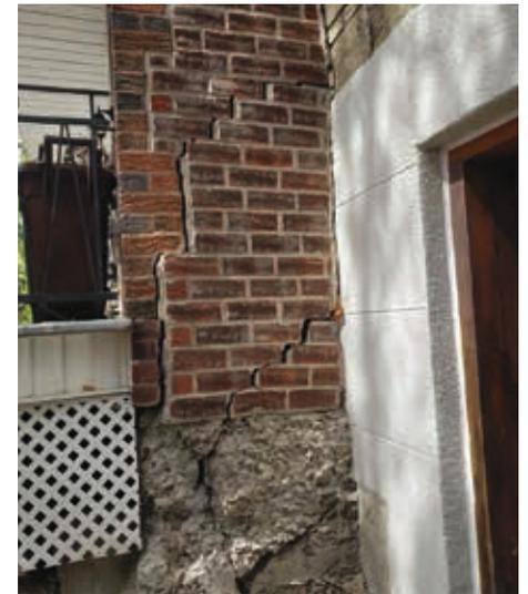
enlignées d'un étage à l'autre, des poutres sous-dimensionnées pour les charges ou encore une portée trop grande pour les dimensions », décrit M. Pelletier. « Ça entraîne une distribution inégale des charges sur les murs et les colonnes, et donc des déformations. »
