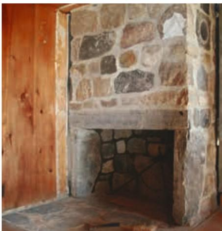
L'usage du ciment, ou du mortier moderne, est toutefois incompatible avec les mortiers traditionnels. Bien que le mortier moderne permette de monter de hauts murs de brique rapidement, il n'est pas recommandé pour refaire les joints sur un bâtiment historique. Alors que le mur massif de maçonnerie traditionnel doit respirer et bouger, l'application du produit cimentaire sur celui-ci vient sceller l'humidité et l'immobiliser, entraînant sa détérioration accélérée. Ce fait, longtemps
