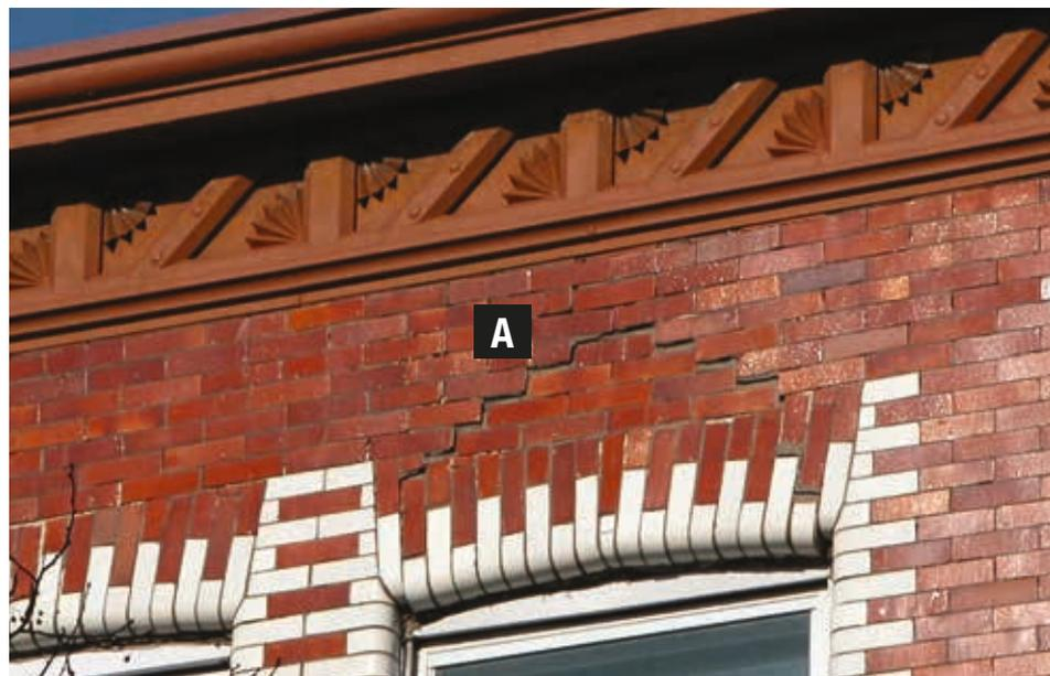
Quant au nettoyage de façade, la prudence est de mise car, si le résultat est spectaculaire à première vue, un travail non professionnel causera des dommages importants à la maçonnerie en attaquant sa surface cuite et durcie. En devenant ainsi plus poreux, le mur sera plus sensible aux cycles de gel et de dégel, ce qui accélérera sa détérioration.
