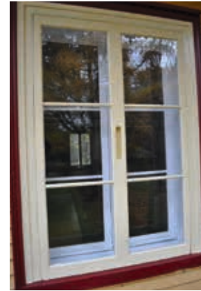
Fenêtre avec châssis intérieurs et contre-fenêtre datant d'environ 1850. ©Clément Locat.
