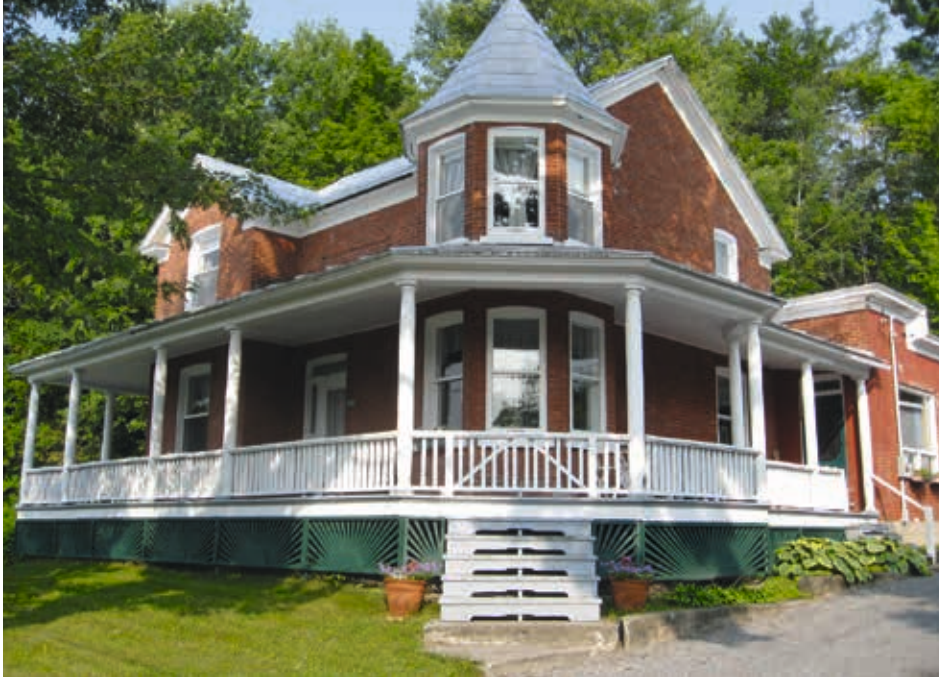
Maison datant de 1915, située à Saint-Barthélemy, ayant conservé tous ses éléments d'origine : fenêtres à guillotine, tôle d'acier sur les toitures et parement de brique. La galerie et sa balustrade ont été restaurées récemment. ©Luce Picard.
