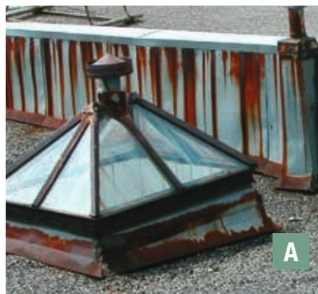
pieds des supports électriques, le lanterneau et son pourtour, vérification de la tôle à la recherche de rouille, ainsi que des joints non calfeutrés. Regardez la corniche pour vérifier la tôle, les joints soudés, les différentes parties des décorations de ferblanterie, l'état général de la peinture. Si vous notez des faiblesses concernant certains de ces points, il serait prudent de contacter une firme spécialisée en toiture ou en ferblanterie.
