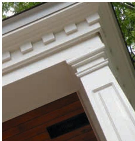
carton épais le profil d'une section adjacente qui correspond à la portion manquante. On transpose ce profil sur un morceau de bois de même épaisseur et de même longueur que la section à remplacer. On découpe à la scie sauteuse ou à la scie à chantourner le profil tracé. On ponce la nouvelle section, on la protège (apprêt, puis peinture ou teinture) et on la fixe à l'aide de vis dont on colmatera les trous pour assurer une régularité de surface.
