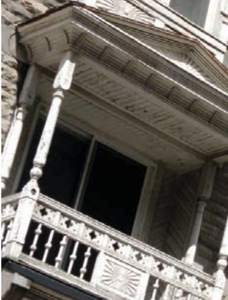
Ainsi l'aisselier, à la jonction du poteau et du toit de la galerie qu'il supporte, reproduit souvent une volute ou des courbes inspirées des coquillages. Le lambrequin, installé à l'horizontale sous la toiture de la galerie, est constitué de la répétition d'un même motif, par exemple une succession de fuseaux ou de potelets. Les barrotins découpés de certains garde-corps créent parfois des motifs particuliers lorsqu'ils sont assemblés les uns à la suite des autres.
