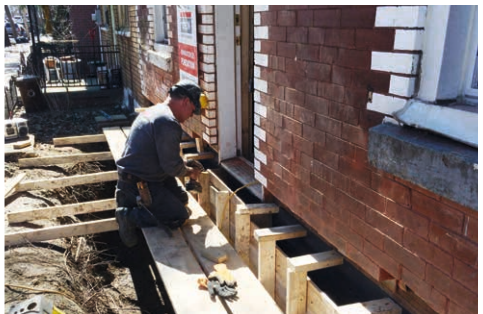
Remplacement d'une fondation en sous-œuvre
