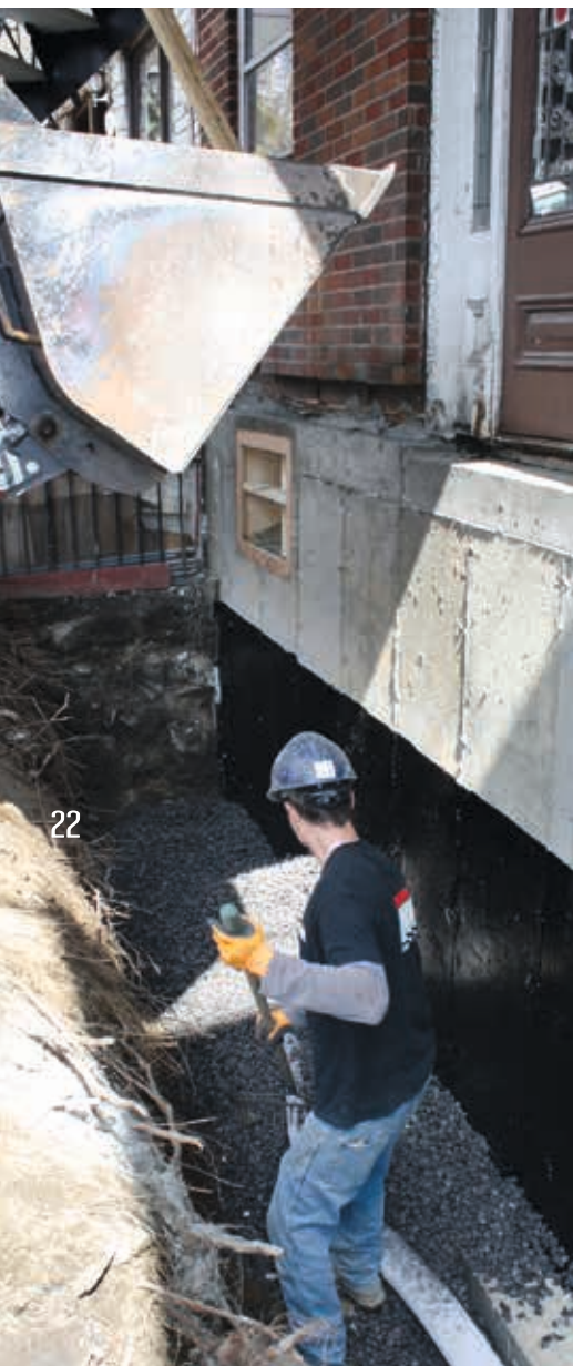
Pose d'un drain français
