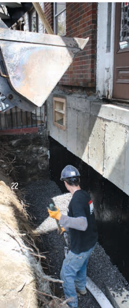
Pose d'un drain français
