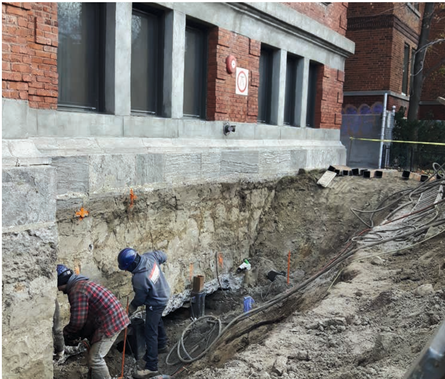
Installation de pieux hydrauliques afin de stabiliser un immeuble affaissé
