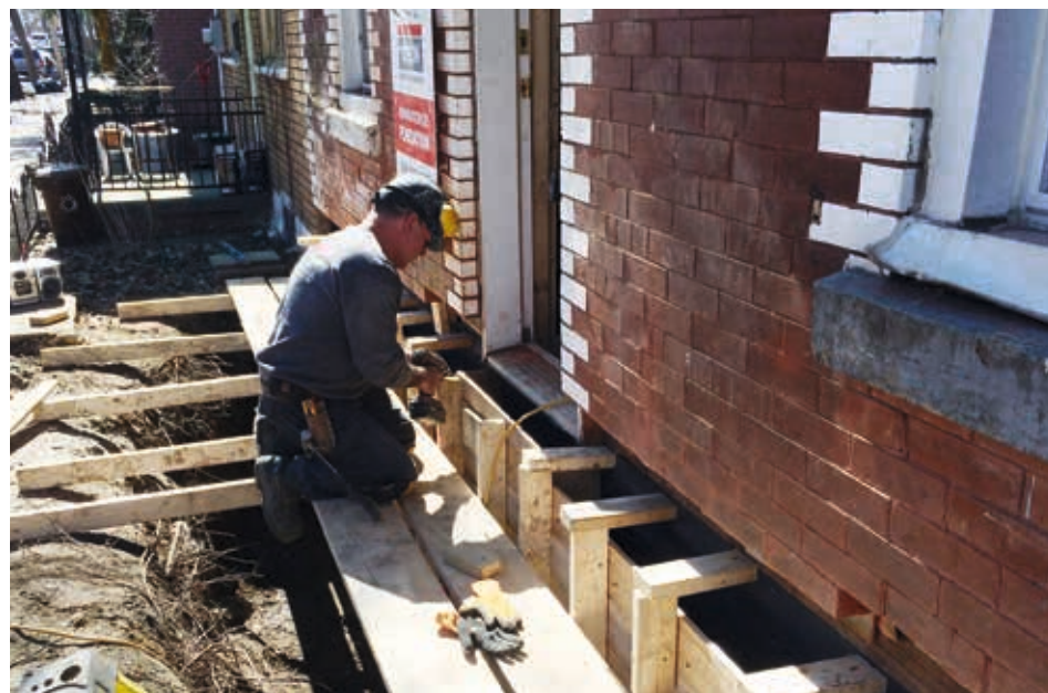
Remplacement d'une fondation en sous-œuvre
